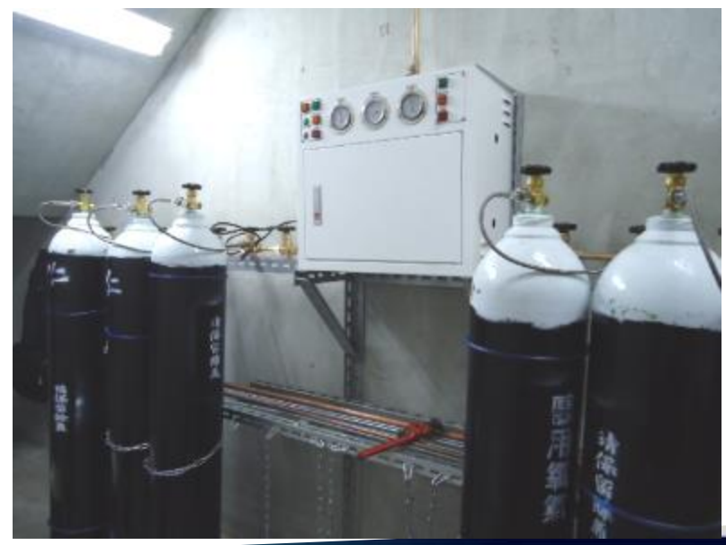
6m 3 鋼瓶型 氧氣鋼瓶
