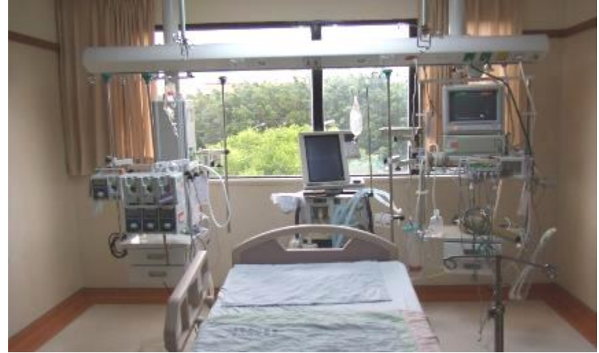
加護病房氣體橋式吊塔
